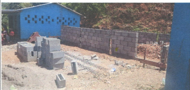
Foto 5: mejoramiento del cerco perimetral
