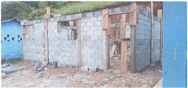
Foto 4: Mejoramiento de aula
