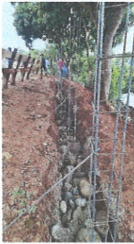
Foto 6: mejoramiento del cerco perimetral
