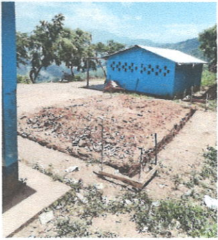
Foto1: Mejoramiento de aula
